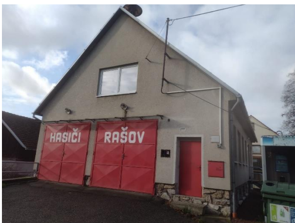
Obr. 23 Budova hasičské zbrojnice
